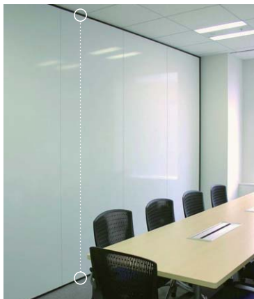
シンクロンは、天井部と床部を専用部品でつなぐ
