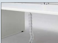
ケーブルダクト
